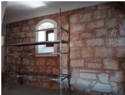
Muro de sillería del antiguo convictorio.
