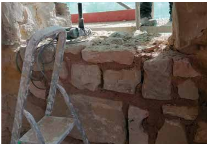
Restauración de la parte interna.
